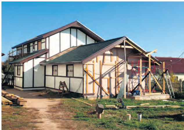
Im Rehabilitationszentrum in Poschitni entsteht ein zweites Wohnhaus.
