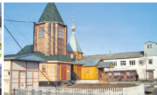
Gefängniskirche und Glockenturm, im Hintergrund ein Gebäudetrakt der Strafkolonie.
